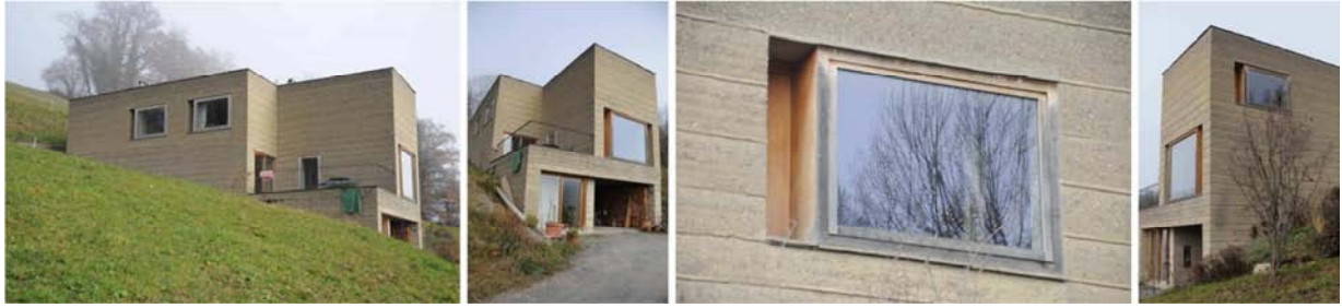
Martin Rauch és Roger Boltshanser családiház Schlins
